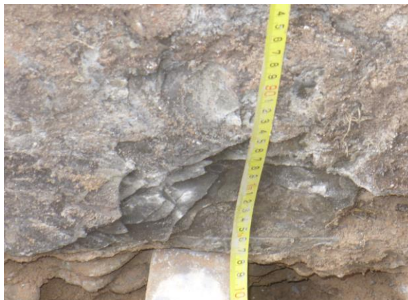
DEZVELIRE 1 (ZID INTERIOR) – Adancime fundare = -1,10m
