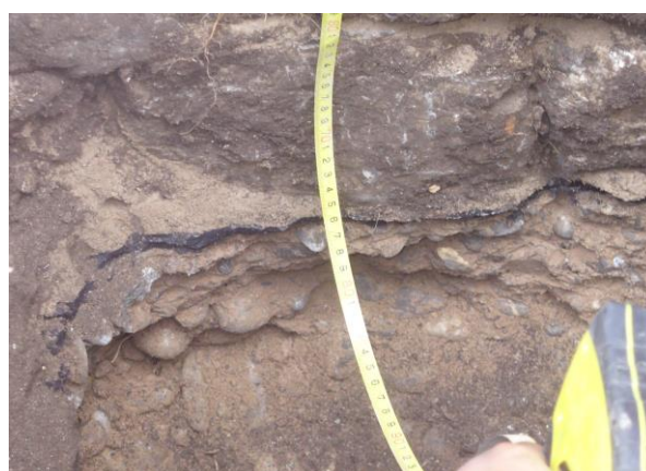
DEZVELIRE 2 (ZID EXTERIOR) – Adancime fundare = -0,80m
