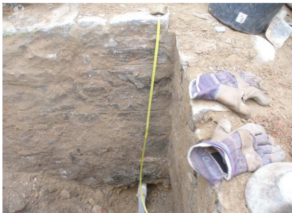
DEZVELIRE 1 (ZID INTERIOR) – Adancime fundare = -1,10m
