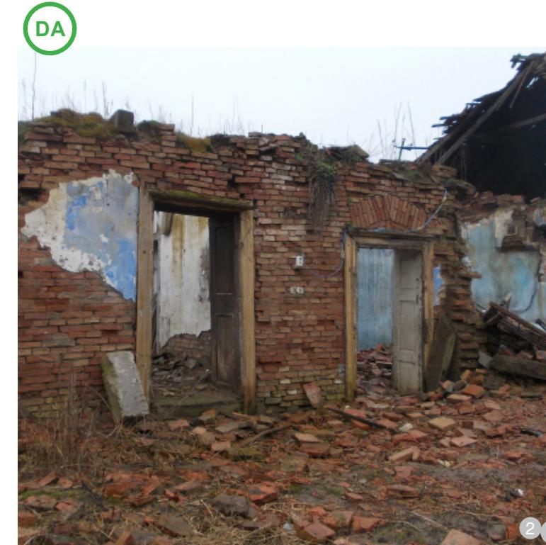
**ASA DA:** Materialele de construcție tradiționale, precum cărămidă. Din păcate nivelul avansat de degradare ne permite observarea metodelor tradiționale de zidărie. (imagine din Budacu de Jos)
