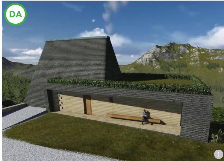
**ASĂ DA:** Exemplu de utilizare a unor materiale compatibile la învelitoare: alăturarea unui acoperiș vegetal/verde la cel acoperit cu șindrilă
