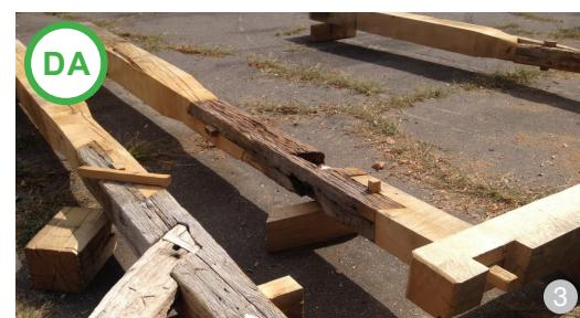
**ASA DA:** Cadre traditionale din lemn în timpul restaurării: un element afectat de degradare nu trebuie înlocuit cu totul.
