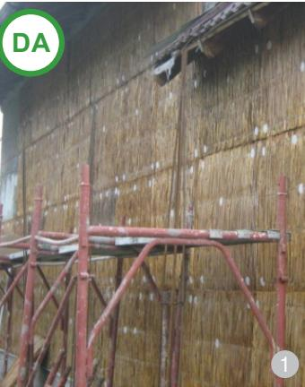
**ASA DA:** Exemple de pereti placați cu panouri termoizolante de stuf
