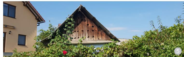
**AŞA DA:** Front de acoperiș tradițional cu traforuri pentru ventilare.
