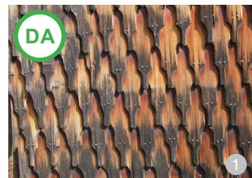
**AŞA DA:** Sindrila și șita, folosite la acoperirea caselor tradiționale, pot fi utilizate și la construcțiile noi la nivelul acoperișului și al pereților.
