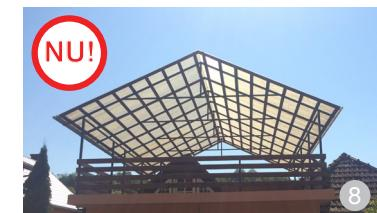
**AŞA NU:** Se va evita utilizarea plăcilor de policarbonat sau din alte tipuri de materiale plastice. Acestea au o durată de viață scurtă și sunt inestetice. (Imagine din satul Fițcău)
