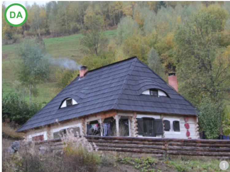
**AŞA DA:** Lucarnele de tip „ochi de pisică” sunt cele mai folosite pentru a lumina un pod mansardat. Acestea modifica nesubstantial volumul acoperișului. Șindrila trebuie întreținută, șindrila din imagine a fost tratată cu ulei ars după aproximativ 4 ani de la montarea ei.
