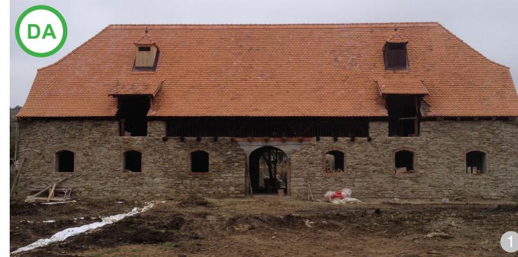
**ASĂ DA:** Zid mixt din piatră de gresie, cărămidă și elemente din beton, care combină tehnica tradițională cu cea contemporană, pentru a corespunde cerințelor de stabilitate etc. – proiect realizat cu finanțare europeană
