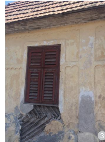
Detaliu de perete al unei case din lemn, soluție importată din alte zone: tencuială din lut cu armătură din șipci despicate, acoperire cu zugrăveală de var (imagine din zona Vălenii de Mureș)
