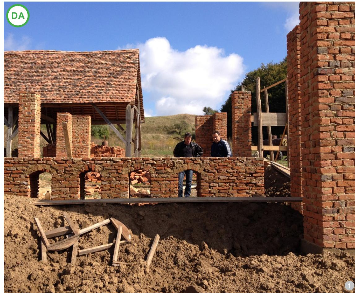
**ASA DA:** Construcție nouă cu pereți și stâlpi din cărămidă și beton: cărămidă tradițională, prin dimensiunile ei mici, se adaptează ușor la orice configurație planimetrică, chiar și în detaliu.
