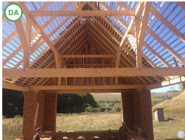
**ASĂ DA:** Șarpantă realizată cu „scaun”, specifică construcțiilor cu deschidere mare
