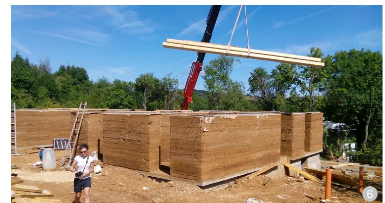
**AŞA DA:** Construcții noi cu pereti din pământ (sau pereti din puzderie de cânepă cu liant pe bază de var hidraulic și nisip).
