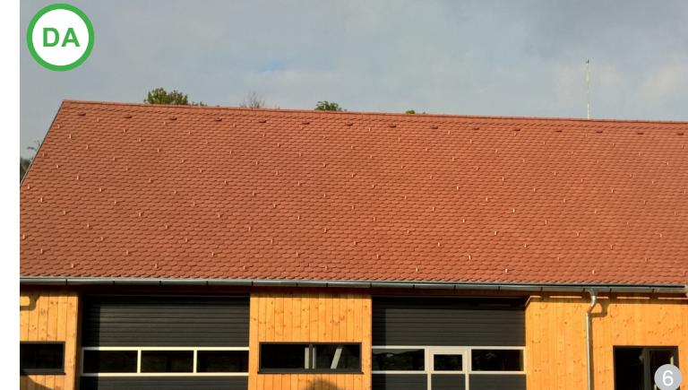
**AŞA DA:** Țigla industrială trasă sau de tip solzi, de formă și cu dispunere specific locală, poate constitui o variantă pentru acoperirea construcțiilor noi de gabarit mare.
