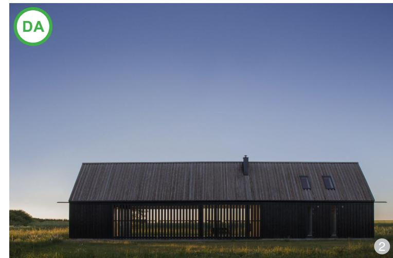
**ASĂ DA:** Necesitatea de lumină poate constitui un factor decisiv în arhitectura fațadei. Pereții vitrați pot fi dublați de un element de umbrire din lemn, care trimite la detaliile de închidere a construcțiilor tradiționale.
