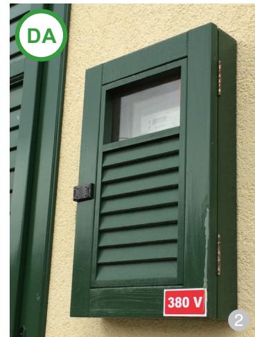
**ASA NU:** Se interzice montarea contoarelor electrice pe fațada de la stradă, acest lucru riscând să deterioreze decorațiile sau alte inscripții încă nedecapate și urăjind în același timp fațada. Se recomandă montarea lor în interiorul incintei, legislația prevăzând că acestea trebuie montate în locuri ușor accesibile și nu neapărat pe fațada de la stradă, aşa cum se întâmplă adesea.
