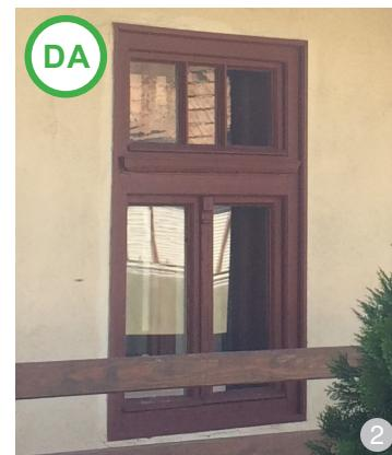
**AŞA DA:** Înainte de revopsirea tâmplăriilor din lemn, acestea necesită o curățare a vopselei vechi. Îndepărțarea vopselei se poate face prin şlefuire sau prin utilizarea unor solventi specifici acestei operațiuni.
