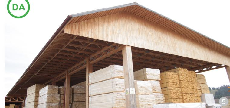
**AŞA DA:** Utilizarea unei structuri din lemn lamelar sau a unei structuri zăbreleite poate fi o soluție practică pentru realizarea clădirilor cu deschideri mari.
