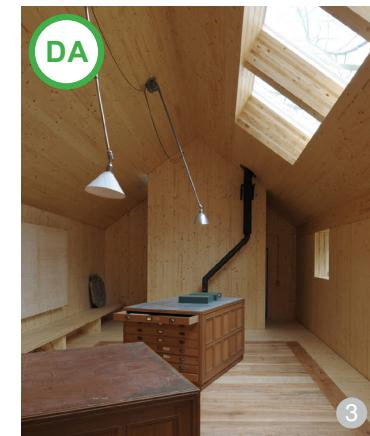
**ASA DA:** Casă cu structură din panouri de lemn lamejar înclaiat; denumirea materialului este CLT (Cross-laminated timber).
