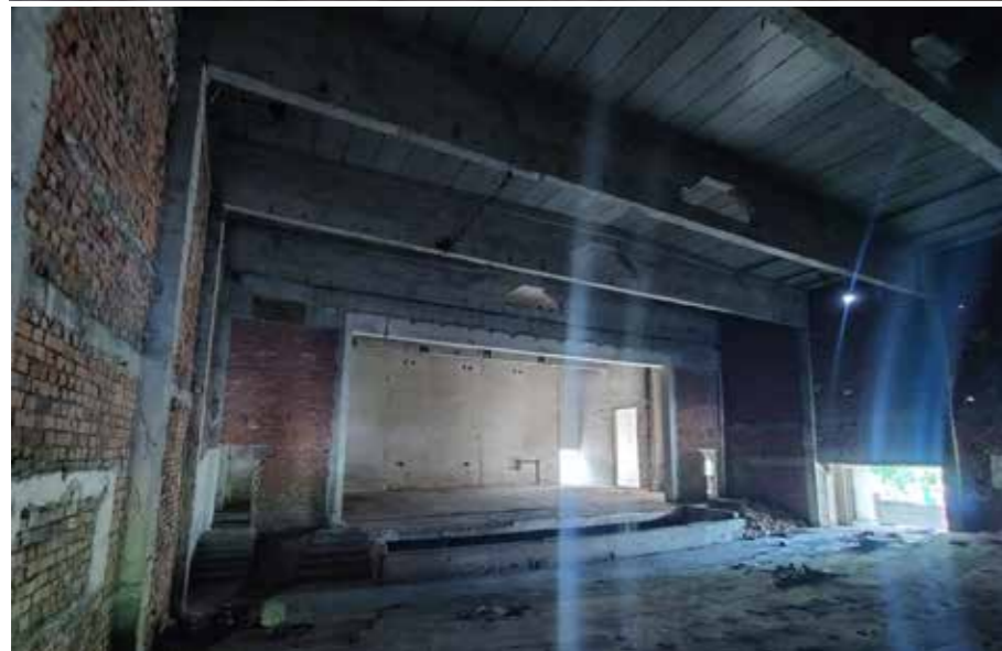
pag. curentă: Sus 1. Clubul UREMOAS - foyeurul etajul 1, 2023 // mijloc 2. sala de spectacol / proiecție - clubul UREMOAS, 2023 // Jos 3. Accesul principal al Clubului UREMOAS, 2023
