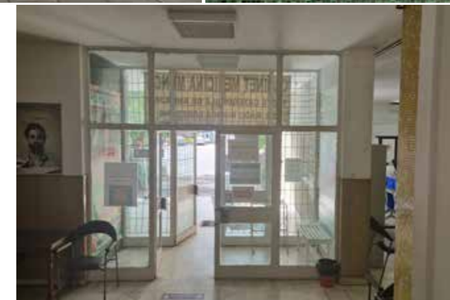
Sus: 1. Interior dispensar Apusuli: Parte a mobilierului și finisajul de pardoseală precum și configurația panoului de ușă (geam armat, culoarea panoului plin). // 2. Mozaic din Dispensarul apusului Jos: 1. Accesul principal -dispensar Apusului - se păstrează tâmplăria din oțel cu geam simplu, câteva din detaliile de mozaic și finisajul de pardoseală. // 2. Scara interioară a dispensarului Apusului.
