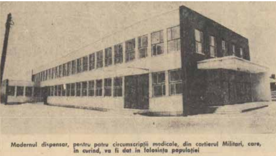
1. Dispensarul Apusului (proiect tip) în Construcțiile sanitare ale anului 1967, Informația Bucureștiului, ianuarie 1967 (Anul 14, nr. 4166-4190): 1-2. // 2. Jos - Dispensarul Apusului 2023 // 3. Jos - Dispensarul Apusului 2023 - accesul principal (cu vîndfangul acoperit) este subutilizat și a devenit un acces secundar din cauza modului în care clădirea este dispusă față de stradă. Se păstrează finisajul cu mozaic verde al fațadelor scurte ale principalelor volume compoziționale.
