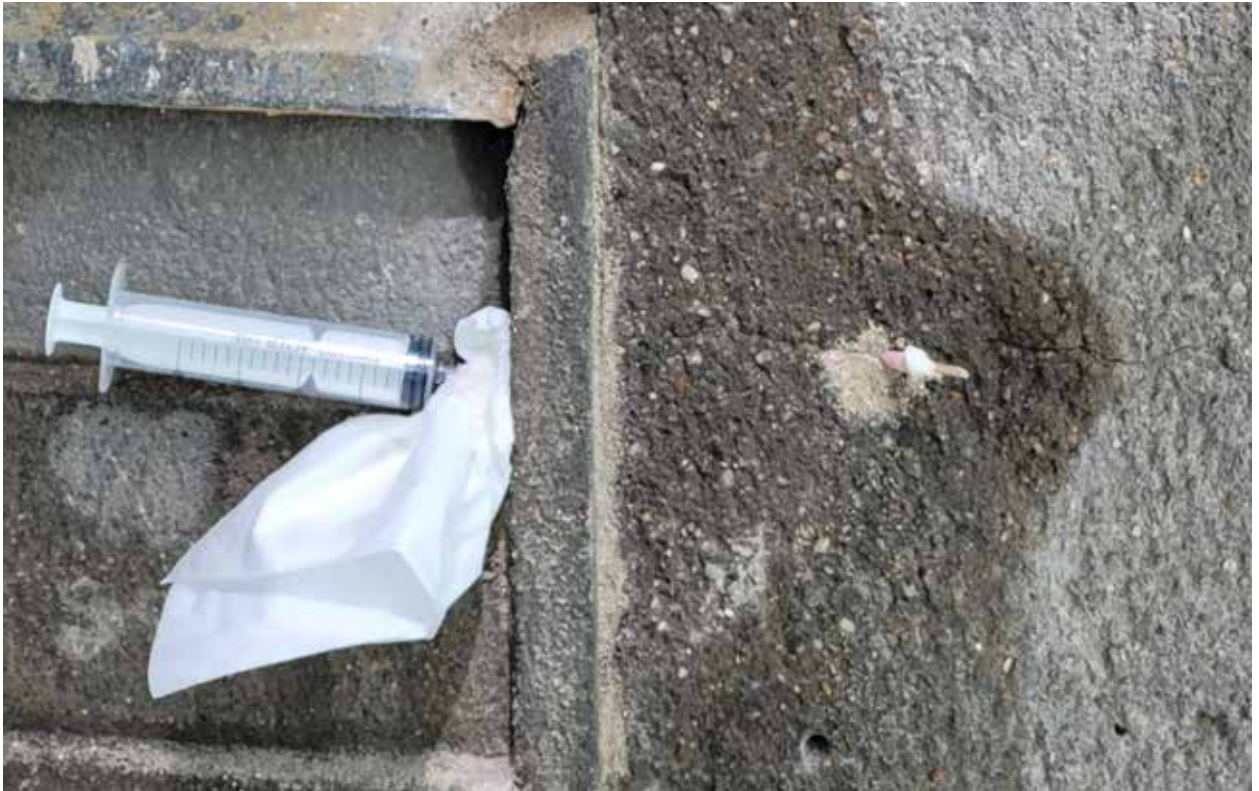
Detaliu consolidare tencuială, folosind injectarea, la Palatul Dauerbach, Timișoara, în cadrul testelor realizate în proiect. Foto: Raluca Munteanu.
