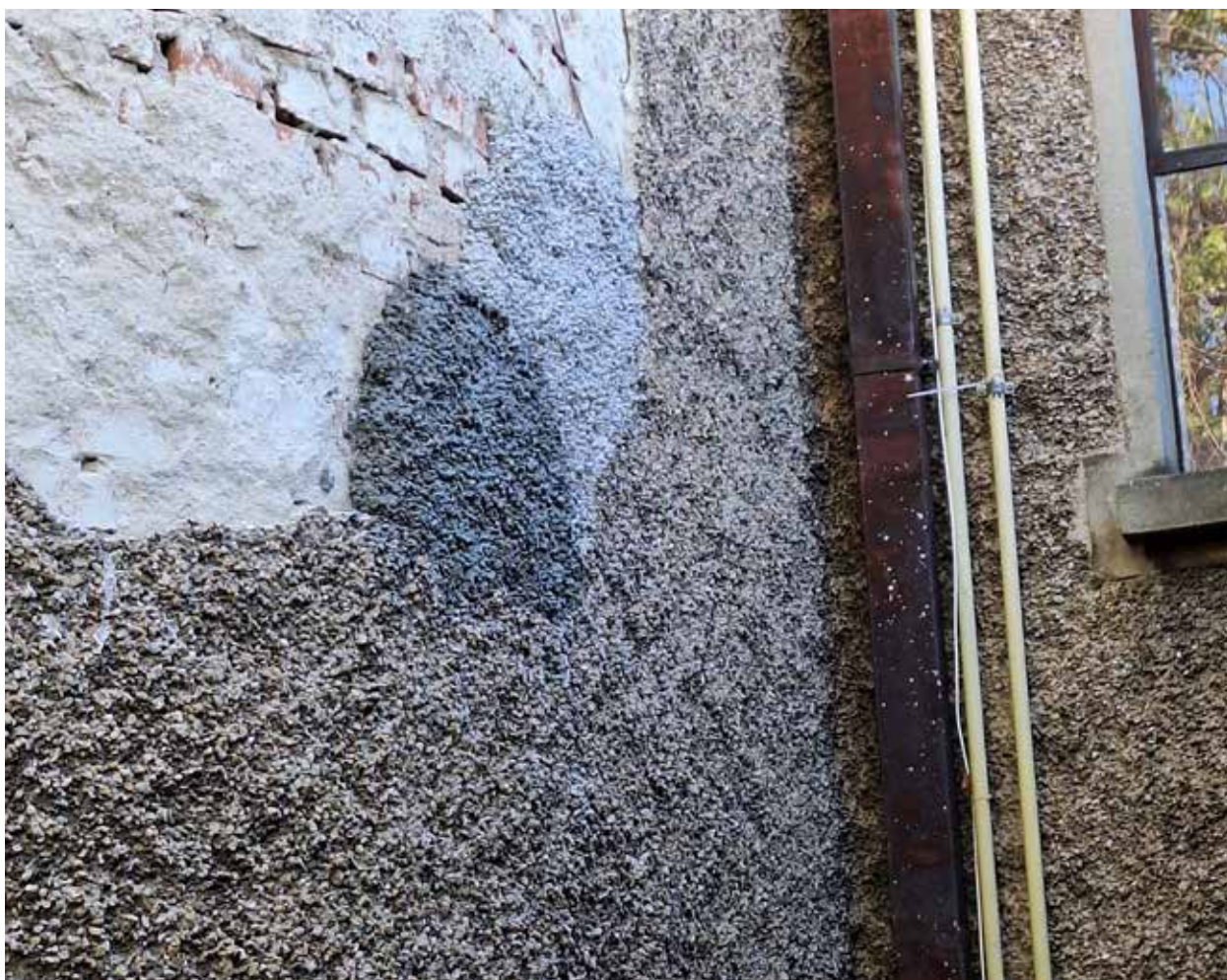
Teste de completare cu material nou pe fațada imobil, București. Foto: Ruxandra Sacaliș.
