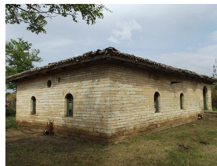
Fig. 38 - Geamia din Albești, jud. Constanța, realizată din zidărie de piatră (1859), la ora actuală nefuncțională
