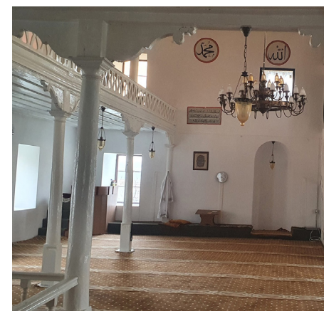
Fig. 25 - Sala de rugăciuni (haram) a Moscheii Mahmut din Hârșova, cu plafon plat și balcon sprijinite parțial de stâlpi interiori
