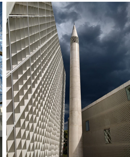
Fig. 82 - Exteriorul Moscheii din Ljubljana, Slovenia, unde nu se citește nicio cupolă, dar apare sugerat designul geometric regulat islamic, cu rol de umbrire a fațadei
