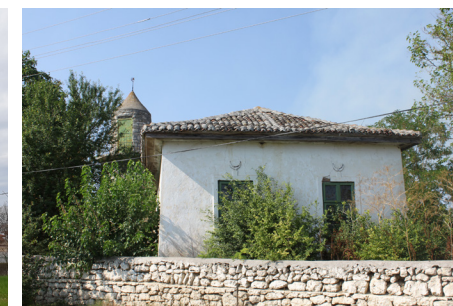
Fig. 51 - Geamia din Cotu Văii, com. Albești, jud. Constanța, asemănătoare locuințelor rurale, din chirpici, cu minaret de piatră (1880)
