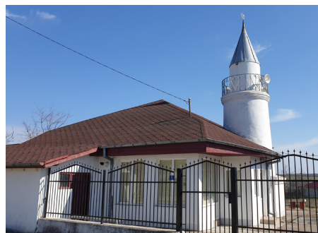
Fig. 68 - Extinderi succesive ale geamiei originale cu diverse spații adăugate, realizate în spiritul tradițional, prin prelungirea pantelor acoperișului, la Dulcești, jud. Constanța
