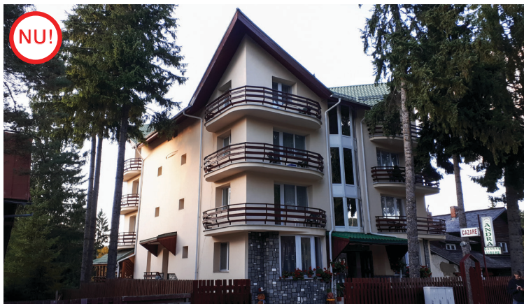
ASA NU: Construcție monovolum de dimensiuni mari, atât în plan, cât și în elevație. Rezolvarea acoperișului contrazice specificul local.
