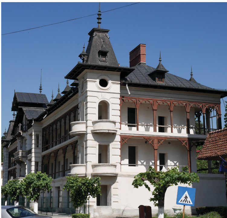
Hotel, Băile Govora. Se observă fațada simetrică, cu accente de colț și tratarea fațadelor cu balcoane, a căror lemnărie mediază relația interior-exterior. Fără a avea drept scop integrarea în specificul local, arhitectura hotelului împărtășește cu cea locală o viziune comună cu privire la conformarea acoperișului, relația interior-exterior și utilizarea materialelor locale.
