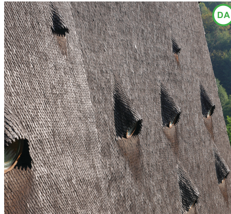
AȘA DA: Acoperiș contemporan din șifă, cu o plastică derivată din tehnologia de execuție care reinterpretează creativ aerisirile podurilor (bagele, fumuri).
