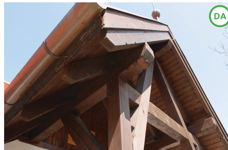
AȘA DA: Rezolvarea îmbinărilor de colț pentru șarpantă în două ape cu căpriori vizibili. Se creează astfel un foisor pentru intrare.
