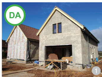
AȘA DA: Casă cu structură de lemn și pereți din amestec de cânepă cu var - denumirea materialului este Hempcrete (Hemp-Lime) - sursa imaginii este - http://thelaststraw.org/building-with-hempcrete-part-1/
