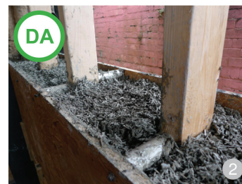
AȘA DA: Casă cu structură de lemn și pereți din amestec de cânepă cu var - denumirea materialului este Hempcrete (Hemp-Lime) - sursa imaginii este - http://thelaststraw.org/building-with-hempcrete-part-1/
