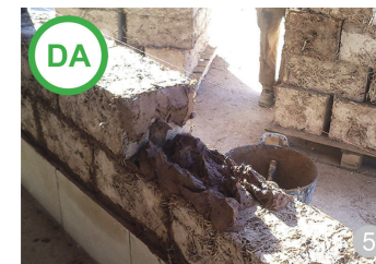
AȘA DA: Casă cu structură din lemn și pereți din baloți de paie sau pereți din blocuri de argilă amestecată cu paie.
