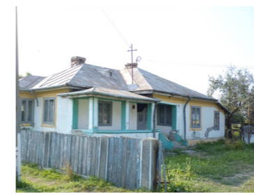
Casă tradițională cu prispă parțială (imagine din Măicănești)
