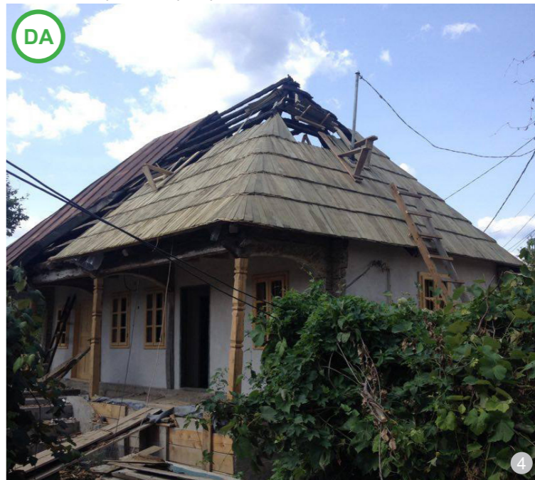
AȘA DA: Învelitoare refăcută cu materialul specific zonei
