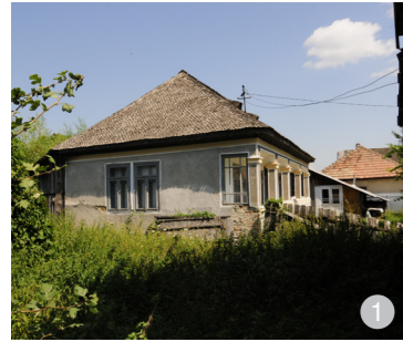
Casă din zidărie de cărămidă cu prispă parțială în zona de acces
