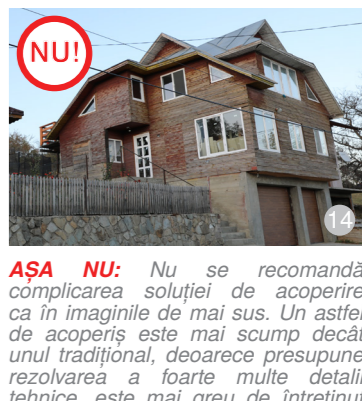
AȘA NU: Nu se recomandă complicarea soluției de acoperire ca în imaginile de mai sus. Un astfel de acoperiș este mai scump decât unul tradițional, deoarece presupune rezolvarea a foarte multe detalii tehnice, este mai greu de întreținut și are un impact neplăcut asupra imaginii de ansamblu a construcției. (fig. 8, 12, 13, 14)
