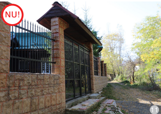
ASA NU: Se va evita placarea stâlpilor porții cu plăci ceramice care imită piatră și folosirea fierului forjat ca material pentru porți.
