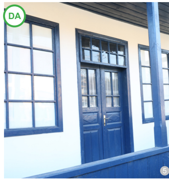
AȘA DA: Se recomandă, pe cât posibil, repararea ferestrelor existente. Dacă schimbarea tâmplăriei este necesară, se recomandă confecționarea unor tâmplării similare cu cele vechi, executate de către meșteri tâmplari din zonă.
