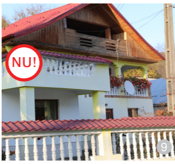
AȘA NU: Sunt de evitat decorațiile și elementele nespecifice zonei și mediului rural, cum ar fi balustrăii de beton din imagine.
