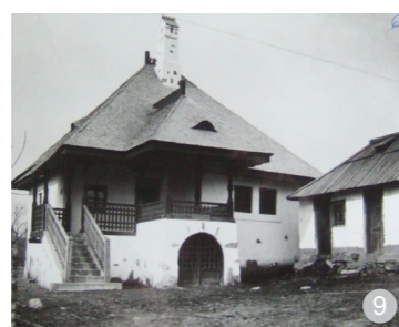
Tip de casă construită de Societatea „Mărăști” în 1918, în Mărăști
