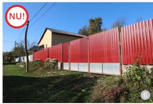
AȘA NU: Se interzice realizarea de împrejmuiți din tablă colorată strident, care reflectă lumina soarelui la modul orbitor.
