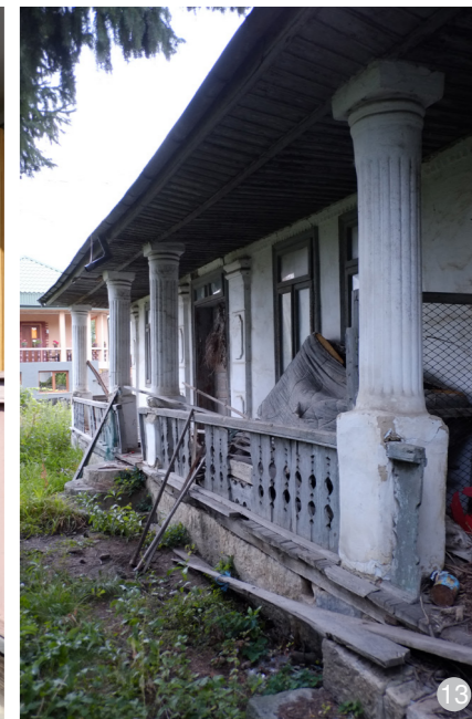
Târnaț cu coloane din cărămidă; zona Clipicești
