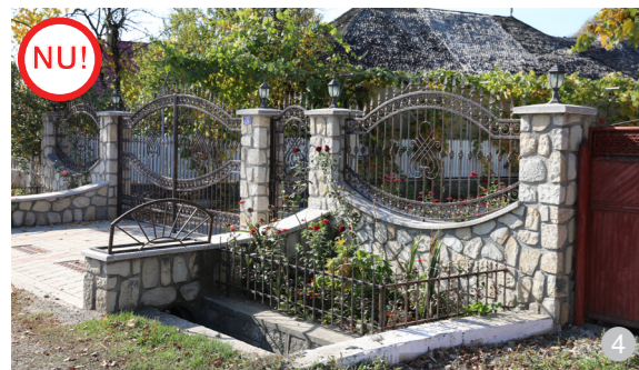
AȘA NU: Nu se recomandă folosirea împrejmuirilor din PVC și fier forjat în stil „rustic”, placările cu faianță sau piatră. Aceasta degradează imaginea așezărilor.
