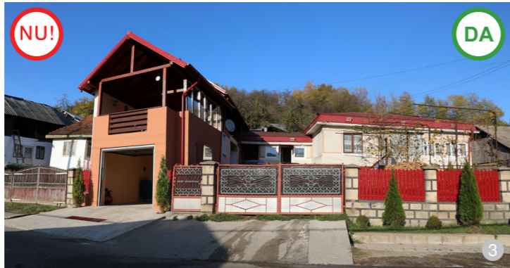
AȘA NU: Se interzice realizarea de rampe din beton care întrerup trotuarul și încălcă carosabilul.
