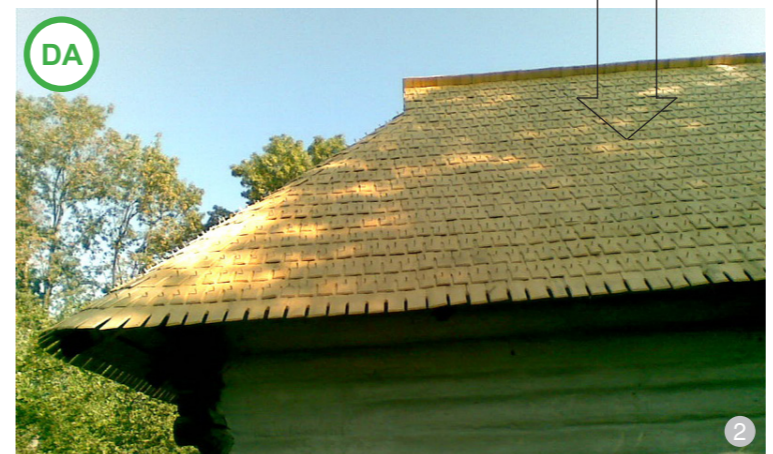
AȘA DA: Imaginile 1 și 2 (înainte și după reparații): șindrila nouă, care respectă dimensiunile, forma și tehnica de montaj ale celei tradiționale, este recomandată la reabilitarea unei construcții existente. Șindrila casei este bătută cu cuie de lemn. Obiectul intervenției a constat în documentarea, demontarea treptată a învelitorii din șindrila și montarea unei învelitorii noi din același material, respectându-se disponerea, dimensiunea și tehnica de confecționare a celei anterioare. Lucrare realizată de o echipă de meșteri șindrilari din Suceava pentru Căsoaia din Paltin de la Muzeul Național „Dimitrie Gusti” din București.
