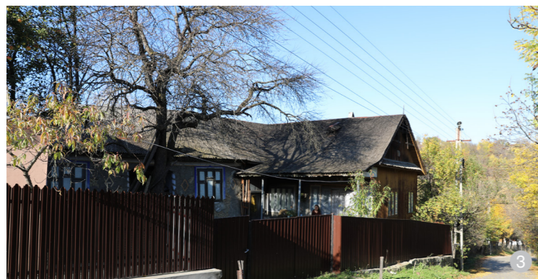
Acoperiș în două ape. Imagine din satul Păulești.
