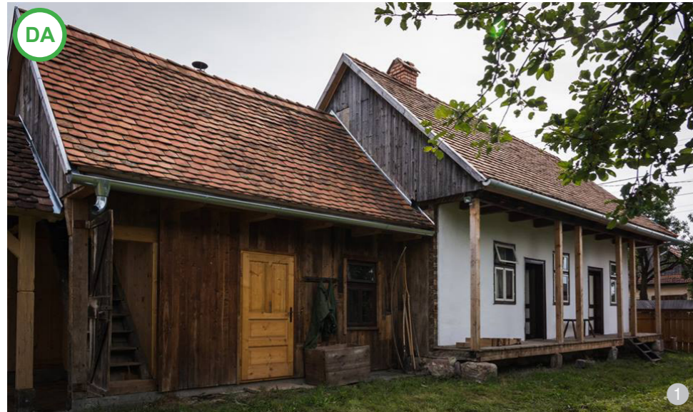
AȘA DA: Amenajarea unor încăperi cu funcțiuni noi în interiorul construcțiilor existente
