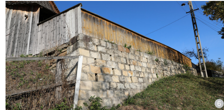
AȘA DA: Împrejmuire/taluz pe teren denivelat; zona Păulești Hăulișca/Spinești
