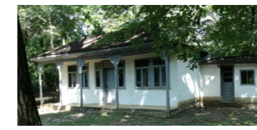
Casă tradițională cu prispă pe toată lungimea fațadei (imagine din Tătăranu)
