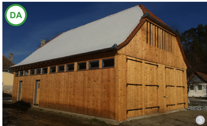
AȘA DA: Șura veche a fost reconstruită din materiale noi, păstrându-se forma șurii vechi. La interior s-au păstrat organizarea spațială și structura de lemn. Exemplu din satul Mălâncrav, zona săsească.
