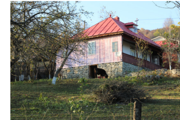
Casă tradițională pe două niveluri: pivniță și locuință (imagine din Jlitia)
