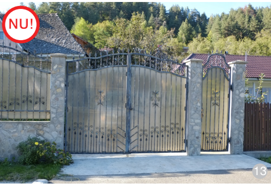
ASA NU: Înlocuirea porții din lemn cu una metalică, placată cu policarbonat, este nerecomandată, pentru că are o durată scurtă de viață. Aceasta din urmă este inadecvată din punct de vedere estetic, zgomotoasă și nu asigură intimitate, din cauza transparenței materialului.
