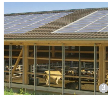
3 Pe acoperișurile orientate către sud se află panouri fotovoltaice
