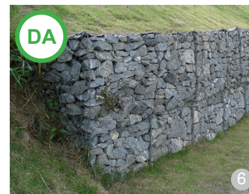
AȘA DA: Zid de sprijin realizat din gabioane
