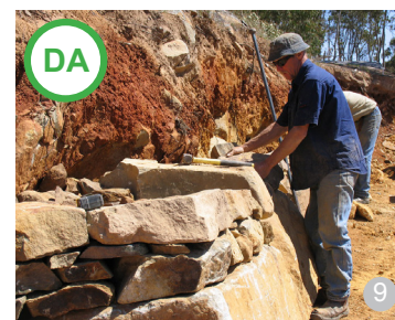
AȘA DA: Zid de sprijin realizat din piatră de carieră, fără beton
