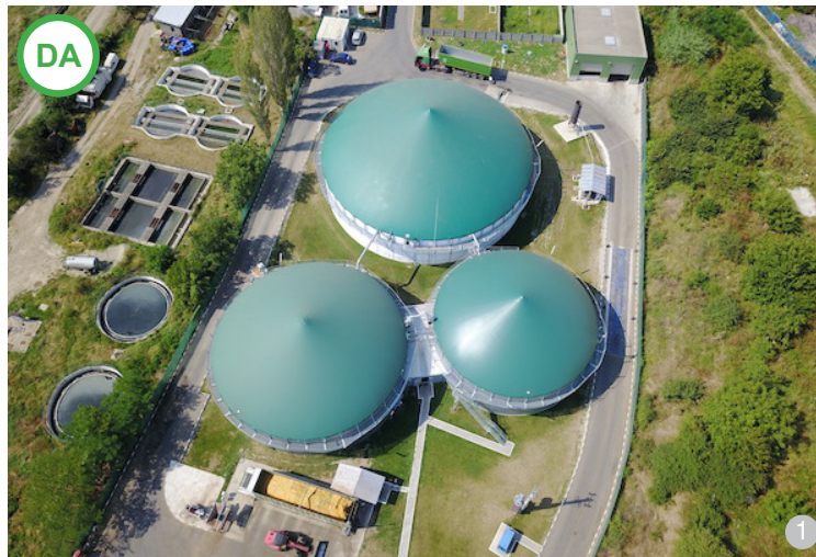
Biogazul rezultat în urma fermentării anaerobe a deșeurilor organice este introdus într-o centrală de cogenerare, de înaltă eficiență, unde se produce energie electrică "verde", regenerabilă: energie electrică, abur tehnologic și apă caldă.
