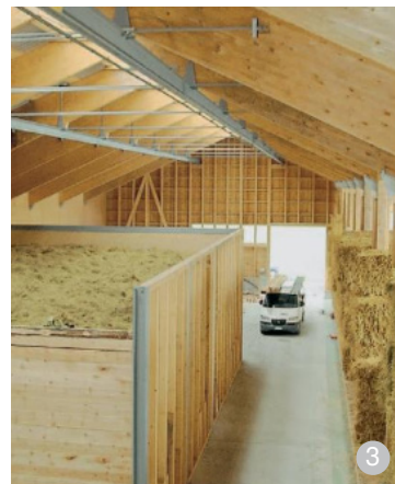
Vedere din sectorul nordic
