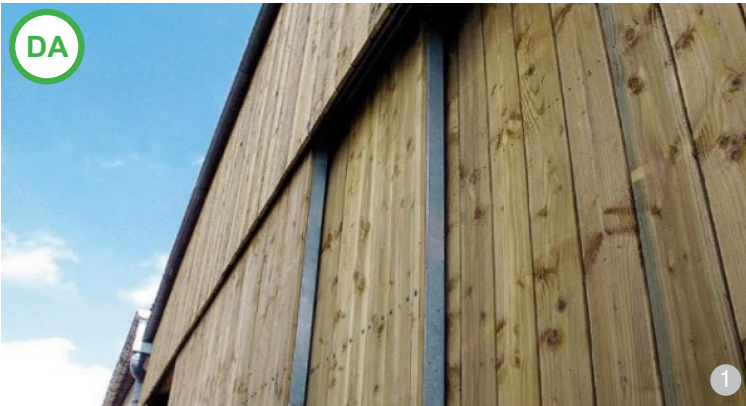
AȘA DA: Lemnul este cel mai potrivit material pentru construcții agricole.
