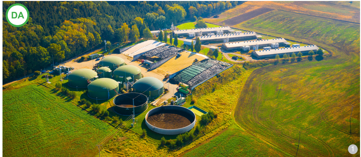
AȘA DA: Amplasarea construcțiilor pe teren este avatajoasă atât din punct de vedere al organizării funcționale a fermei cât și a folosirii particularităților terenului. Se identifică foarte ușor sectoarele de activitate și este asigurată separația vizuală dintre zonele curate și cele cu noxe. Extinderea fermei este posibilă cu păstrarea fluxurilor tehnologice.
