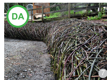
AȘA DA: Zid de sprijin viu realizat din împletitură de arbuști (alun)
