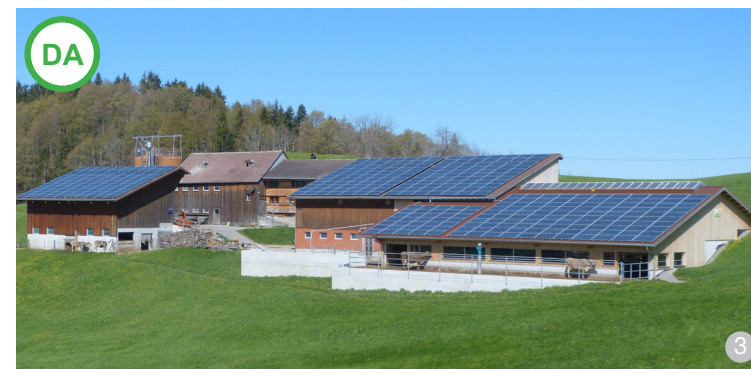
Acoperișul generos al fermei este folosit pentru producerea energiei electrice (panouri fotovoltaice) și a apei calde (panouri solare). Aerul cald de sub panourile fotovoltaice este folosit pentru uscarea paielei.
