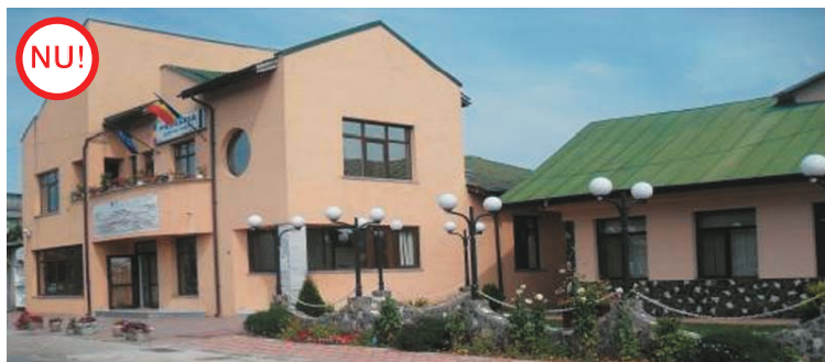
AȘA NU: Se va evita realizarea de acoperișuri cu pante inegale și volumetrii complexe.
