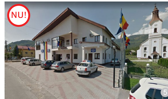
ASA NU: Chiar dacă există spațiul necesar pentru o amenajare verde, cu un spațiu de primire a comunității, pavajul cu parcajele nu lasă clădirea să respire, prin prioritizarea automobilului.
