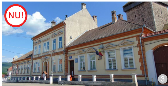
ASA NU: Chiar dacă s-a luat în considerare siguranța pietonilor prin amplasarea unui șir de bolarzi între trotuar și carosabil, accesul în clădire nu este realizat în manieră reprezentativă pentru funcțiunea administrativă.
