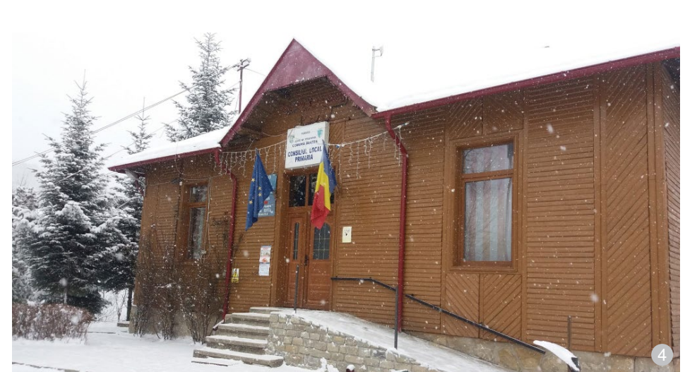
Primăria din satul Berteș, sat de munte, județul Prahova. Clădire izolată, care preia tipologia clădirilor specifice zonei (volumetrie, materiale etc.).
