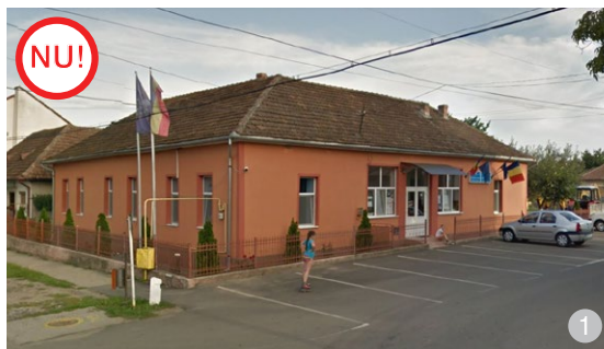
ASA NU: Profilul stradal nu se continuă și pe partea cu accesul, îngreunând circulația oamenilor prin plasamentul parcărilor în detrimentul trotuarului. Parcajele sunt așezate și marcate necorespunzător față de șosea.
