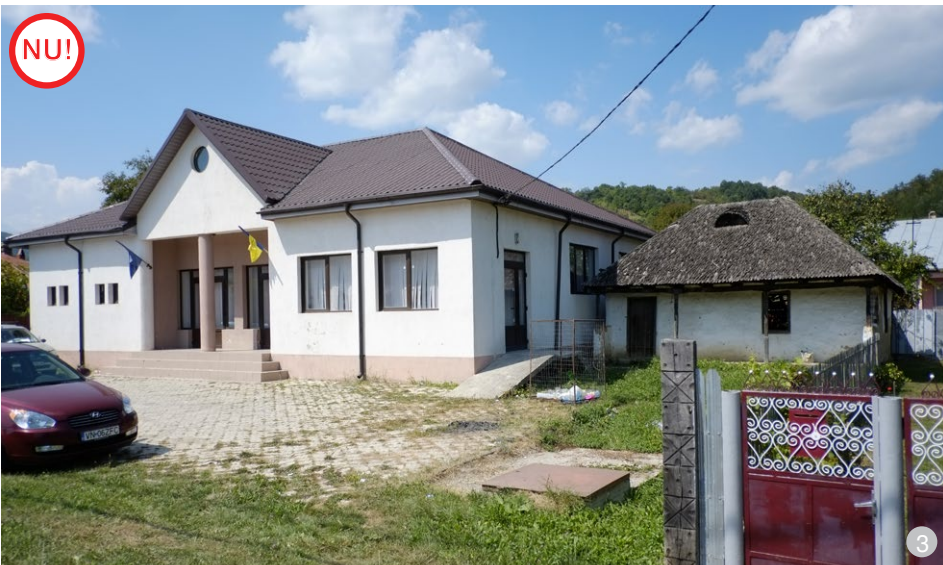
Clădire administrativă din satul Colacu, județul Vrancea
