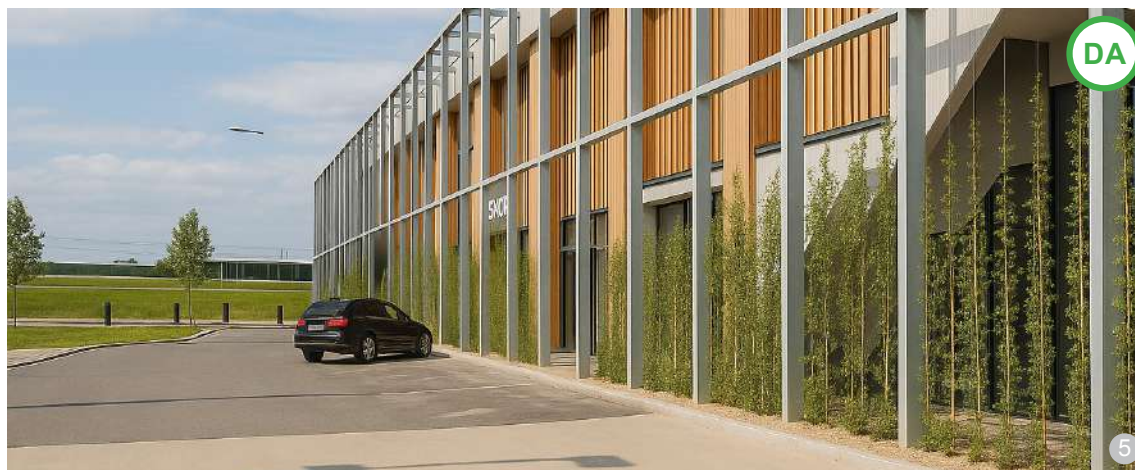
AȘA DA: Fațada este ritmată de o rețea verticală care fragmentează masa construită și pregătește integrarea unei perdele verzi. Umbrirea parțială, rezultată prin dispunerea montanților metalici, precum și alternarea zonelor vitrate cu zonele pline reduc percepția de volum masiv și contribuie la o relație vizuală mai blândă cu spațiul public și cu peisajul construit din jur. Construcția oferă spații de primire a pietonilor care sunt împrejmuite de perdeaua vegetată, aspect ce contribuie la confortul utilizării sau traversării spațiului.
