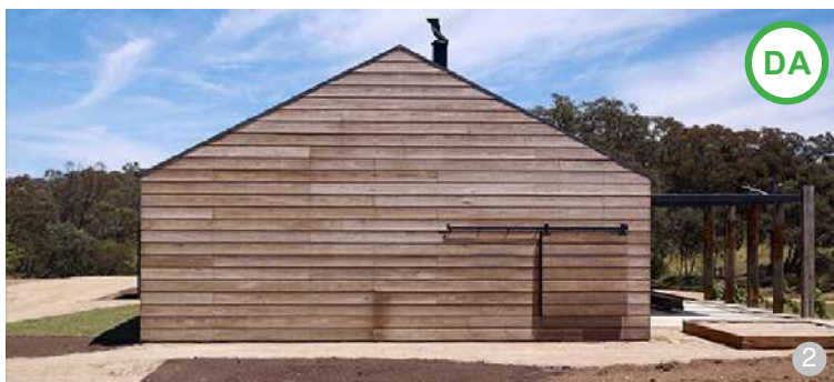
Un mod de placare cu lemn pentru integrarea în peisajul natural și arhitectura locală
