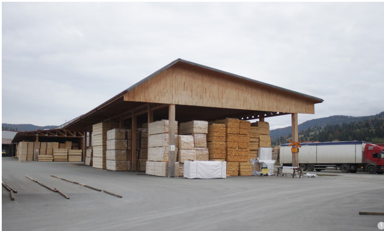
Structură din lemn pentru o hală de depozitare.
