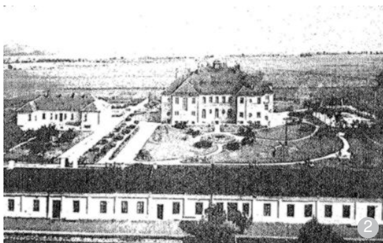
Perioada Industrială: Fabrica de zahăr de la Bod (județul Brașov), construită în 1889. Este singura fabrică ce funcționează neîntrerupt de 130 de ani. Nu este înscrisă pe lista monumentelor istorice.
