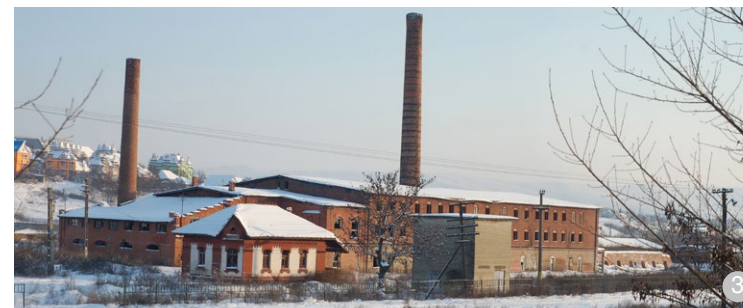
Perioada Industrială: Fabrica de cărămizi din Ciurea, construită în 1891. Este înscrisă pe lista monumentelor istorice din județul Iași, ca obiectiv de valoare locală.
