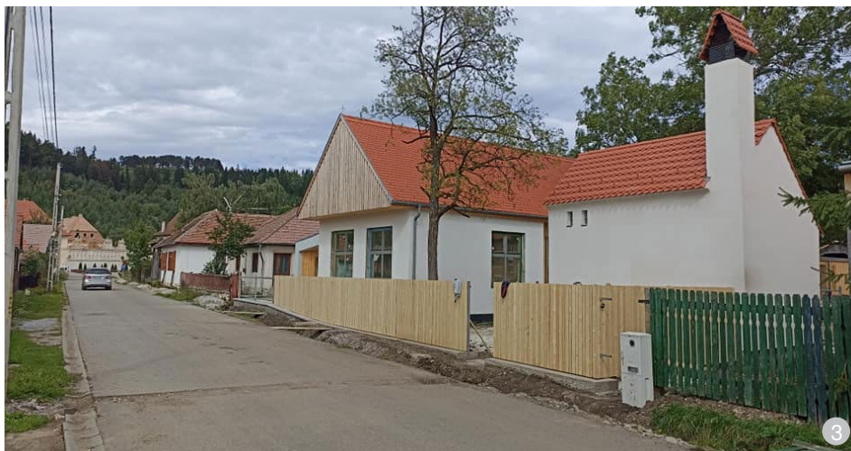
Tipologie de clădiri contemporane încadrate în specificul local. Volumul este dispus de-a lungul parcelei, ținând cont de protecția a trei monumente de importanță națională, într-un țesut rural valoros, cu trei arbori existenți și păstrați pe teren. Intervenția este realizată de Larix Studio.
