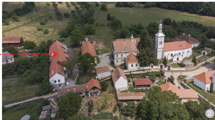
AȘA DA: Construcția se integrează foarte bine în peisaj atât ca gabarit, cât și ca materiale, formă și specific local.
