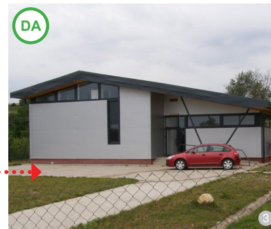
ASA DA: Volumetria se încadrează în contextul rural. O îmbunătățire pentru acest tip de proiect este alegerea unui finisaj exterior din lemn, într-un sistem de fațadă ventilată.
