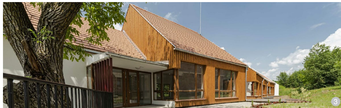
AȘA DA: Volumele din spate urmează arhitectura clădirilor anexe ale gospodăriilor cu volume mai mari, dar dispuse pavilionar, cu finisaj de placaj de lemn.
