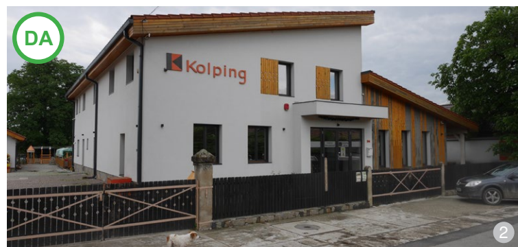
ASA DA: Logoul instituției este realizat și așezat pe construcție într-o manieră atentă la arhitectura și cromatica construcției, rezultând o imagine coerentă.
