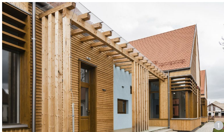
AȘA DA: Umbrarele de pe fațada estică sunt din materiale păstrate ca atare, în nuanțele lor naturale, și nu măscate.
