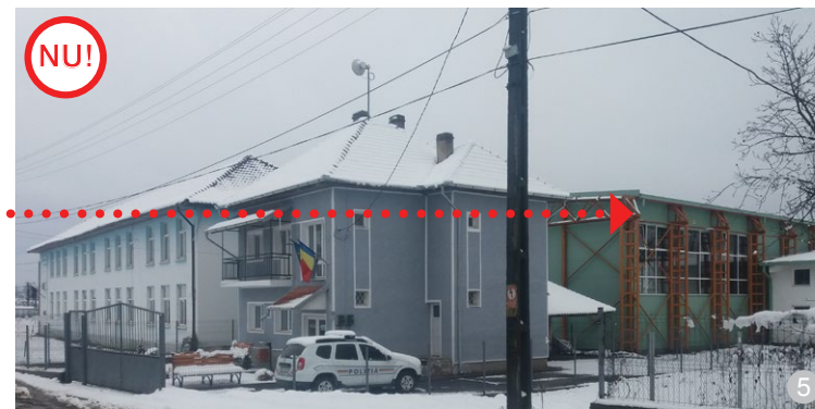
ASA NU: Prin volum, structură, culoare, sala de sport este foarte prezentă la nivelul străzii și creează o notă discordantă față de contextul construit existent atât la nivelul parcelei, cât și la nivelul vetrei satului.
