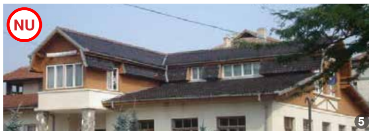
AȘA NU: În cele mai multe zone, acoperișul este în patru ape, cu pante egale și rezolvări clasice pentru intersecții de volume. Ruperile de pantă nu sunt specifice zonelor rurale din România. Se recomandă evitarea utilizării mai multor pante pentru acoperișul aceleiași clădiri.
