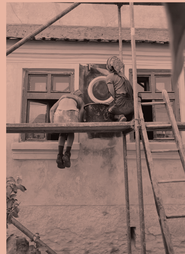
Şantierul - Şcoala de restaurare a faţadei albastre de la Şona, Şcoală de vară 2021 © Diana Iabruşu ( www.albastru.ro ) & Ioana Viorica Georgescu
